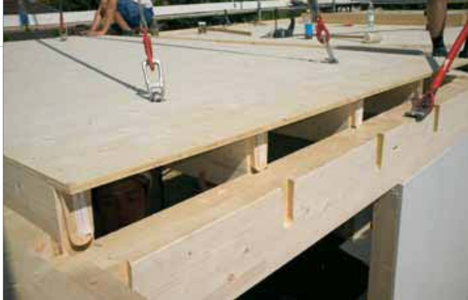
Altbewährtes mit modernster Technik gefertigt: Schwalbenschwanzverbindung
