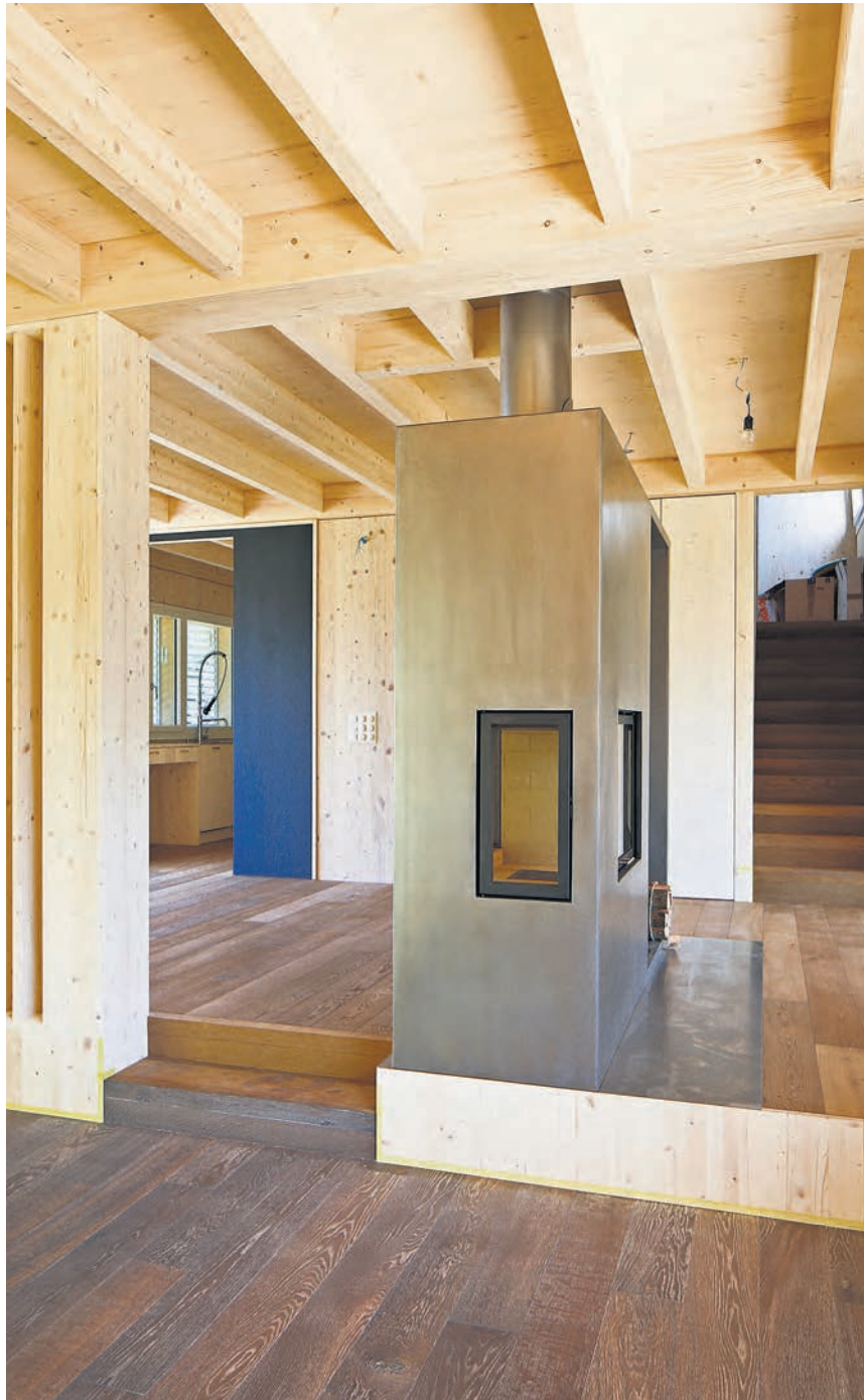
Alternativ. Das Ein-Ofen-Haus setzt auf Holz, verzichtet auf eine automatische Lüftung und kommt mit einem Holzofen im Wohnraum aus. Foto Andreas Fahrni
